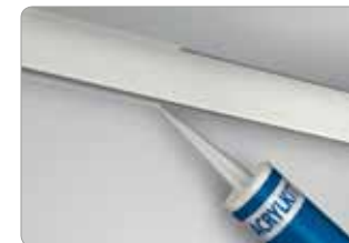
Peitä kiskon ja seinän sauma
