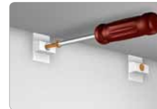
Ruuvaa kiinnike seinälle (40 cm välein)
